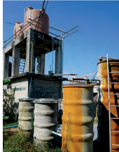
Die Solaranlage versorgt die Wasserpumpe mit Energie, die Filteranlage reinigt das Grundwasser mit natürlichen Materialien – aus dem Hahn fließt Trinkwasser.
